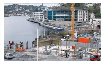
BOLIGBLOKKER: Nærmest ser vi fundament og p-kjeller for de to første av tre boligblokker. En blokk bygges ut over pælene i sjøen.
