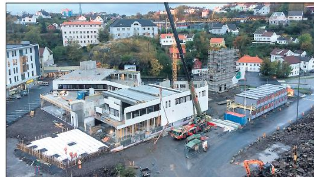
MACGREGOR-KONTORBYGGET: Nybygget på 7.751 kvm settes opp for en stor del av prefabrikerte elementer. Her byggeplassen fotografert fra toppen av en av de svære kranene. FOTO: JBU
